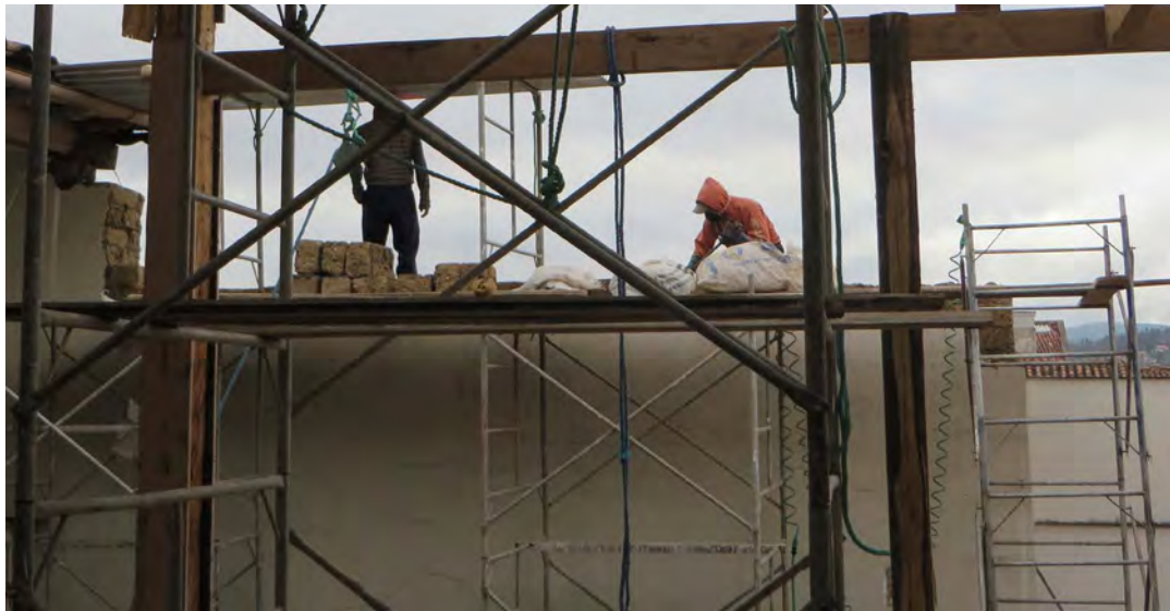
Muro con desplome e intervención:desmontaje de la parte alta del muro y atado del muro con muro perpendicular mediante viga collar de madera. Casa Carvallo (LA izquierda / ES arriba y derecha)
