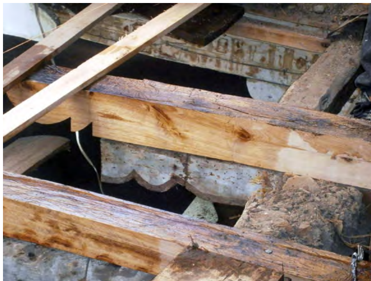
Alargamiento del alero con nuevas viguetas (LA)
