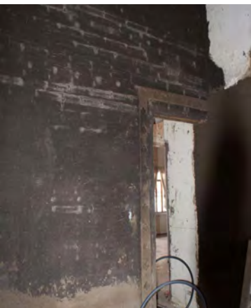
Muros de bahareque
