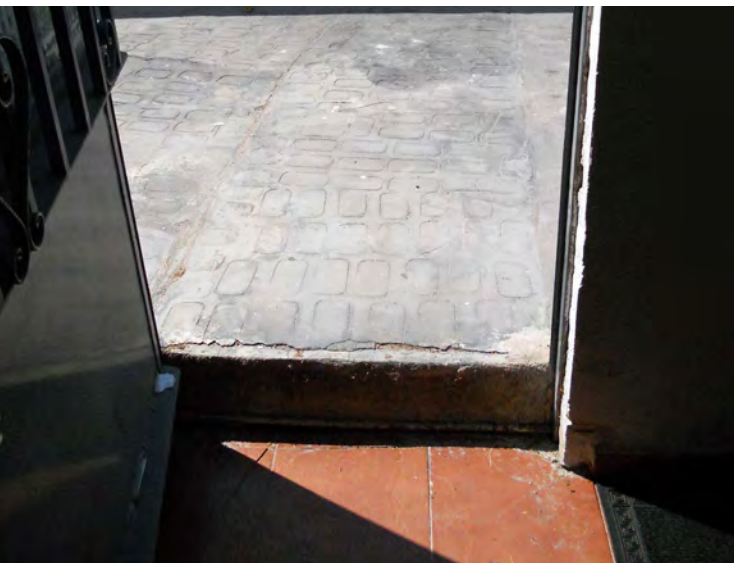
Subida del nivel de la calle (ES)
