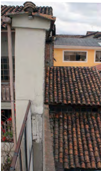
Muro con desplome e intervención:desmontaje de la parte alta del muro y atado del muro con muro perpendicular mediante viga collar de madera. Casa Carvallo (LA izquierda / ES arriba y derecha)
