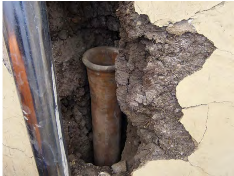
Sustitución de tubería defectuosa en la Casa Carvallo (LA)
