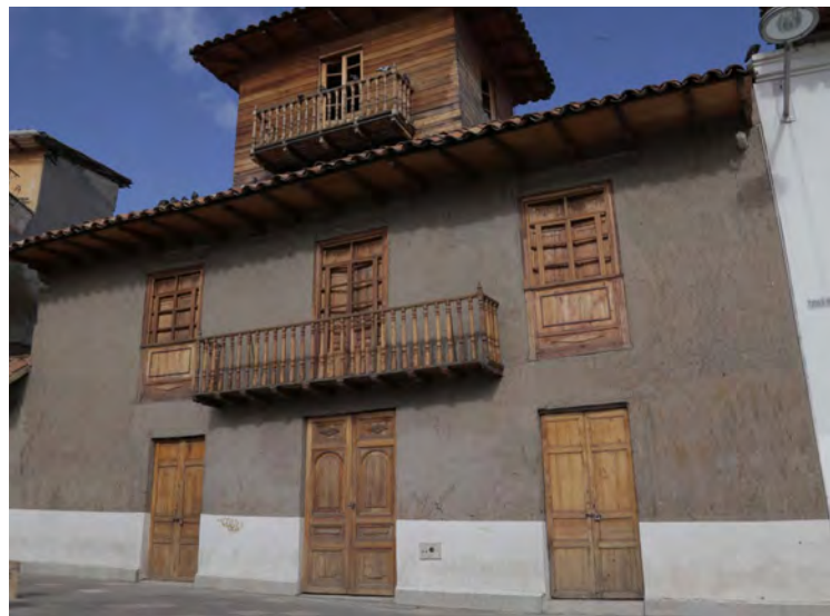
El mismo muro después de refacción del revoque (AR)
